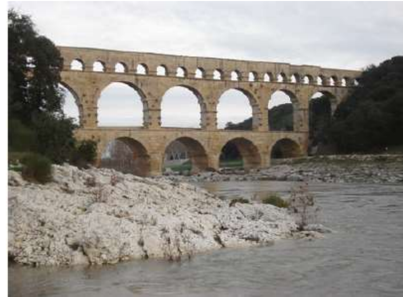
Pont du Gard in Nîmes-Südfrankreich 1. Jh. v. Chr. von Römernerbau, 19.Jhrd. restauriert
